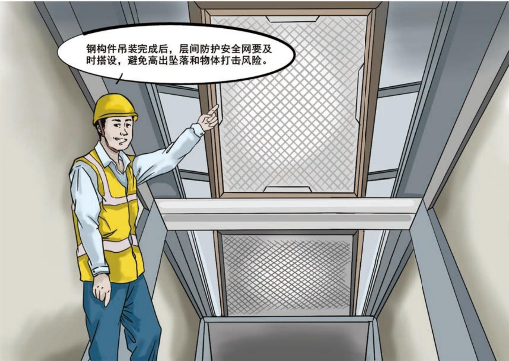
钢构件吊装完成后，层间防护安全网要及时搭设，避免高出坠落和物体打击风险。
